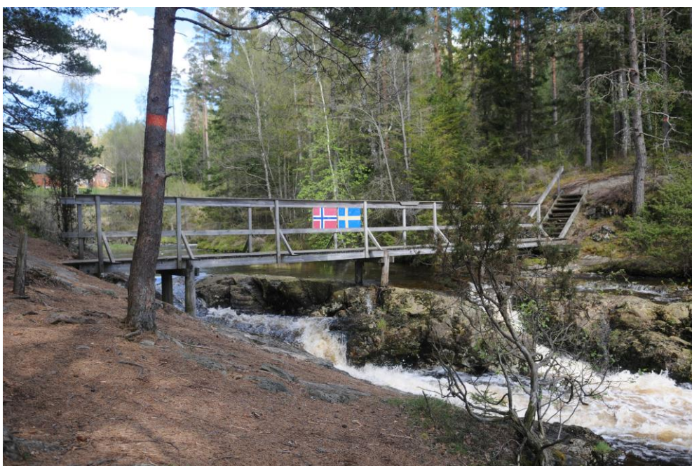
Elgåfossen. Oppstrøms den høye fossen – grensebrua med flagg som viser riksgrensa. Foto: Svein Nørheim
