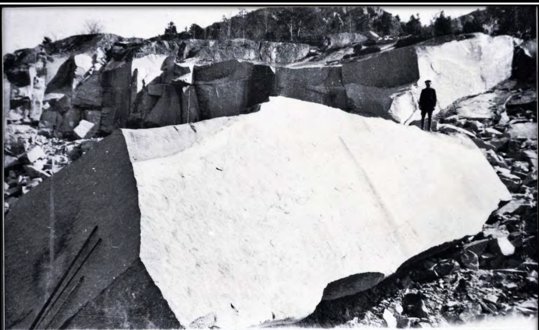
Monolitemnet etter første løsgjøring. Det "rauset" nedover og la seg til ro på planet. Vekten ble anslått til 5 á 600 tonn.
