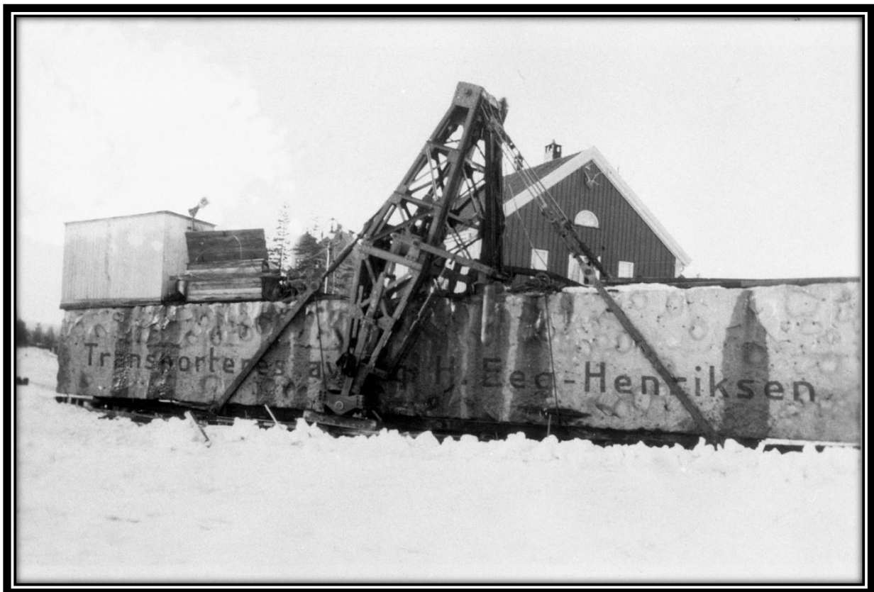
Transporten fra havna til Vigelandsanlegget.
